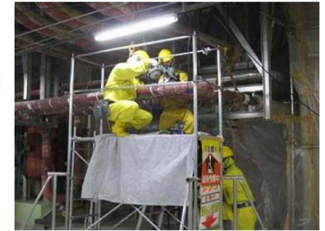
ふげんタービン設備の解体工事
