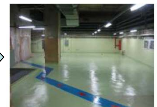
解体撤去後の第5給水加熱器付近
