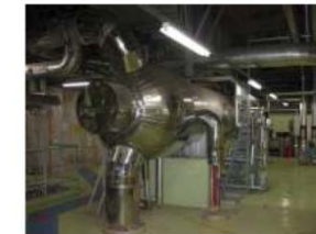
解体撤去前の第5給水加熱器付近
